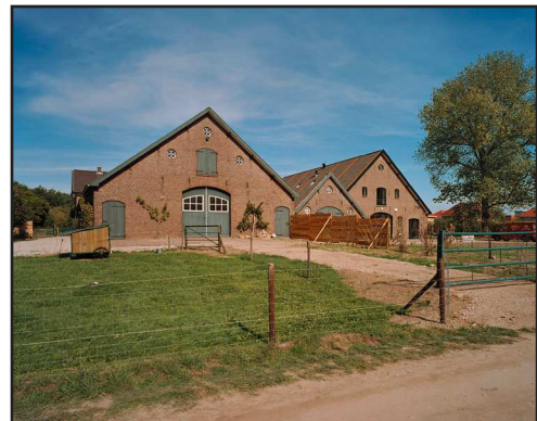
Zuidgevel van vml. boerderij Lindensbouwing. Foto door C.S. Booms, 2003. (Bron: RCE, nr. 500.823).
