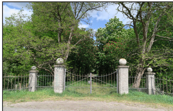
5. Oprolaan en toegangshek op de dijk.
