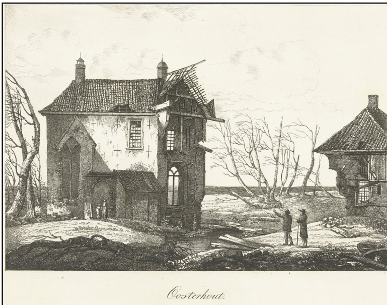
Beschadigingen door een dijkdoorbraak bij Oosterhout, vermoedelijk in 1820. Het gebouw lijkt een kerk te betreffen, mogelijk de kerk uit 1795 ten noorden van het Huis te Oosterhout. (Bron: Rijksmuseum, nr. RP-P-OB-83.686).
