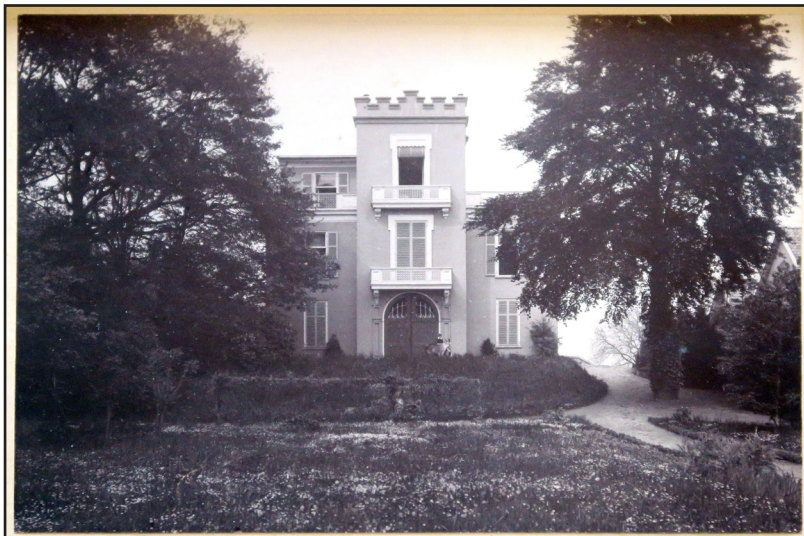
Foto van het huis en de tuin vanuit het zuiden, ca. 1910-1930. De beplanting is verder uitgegroeid. Het huis ligt duidelijk verhoogd. Recht voor het huis is een tuinvaas aanwezig. (Bron: Coll. Huis Oosterhout).
