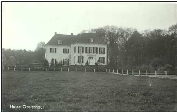
Foto van de noordgevel. Situatie na 1932. (Bron: Dos. F. Ameschot; coll. hist. vereniging).
