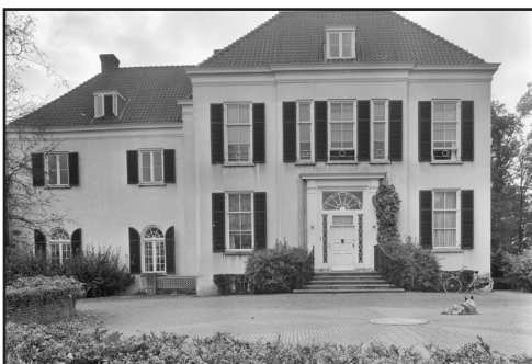
Noordgevel van het huis. Foto door A.J. van der Wal, 1966. (Bron: RCE, nr. 108.922).
