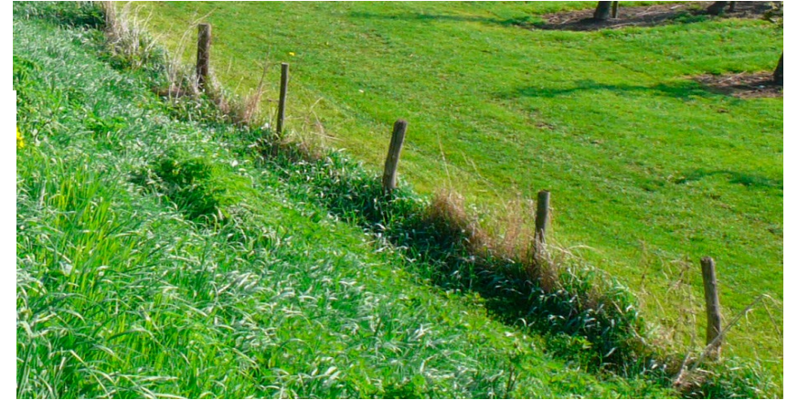
Eén type eenvoudig raster (houten palen en draad, diameter max. 15cm). Beheerstrook scherp begrensd tov landgebruik omgeving
