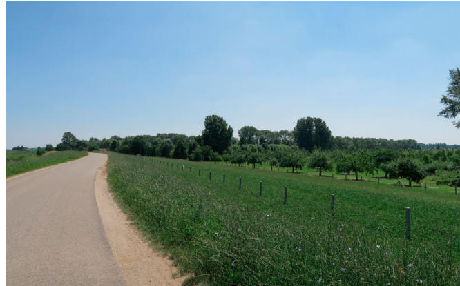
Afb. 2.53. Leeflaag berm meegedaan in stabiliteitsberekening. Locatie foto: Achterweg-Beusichemsedijk 17 Culemborg
