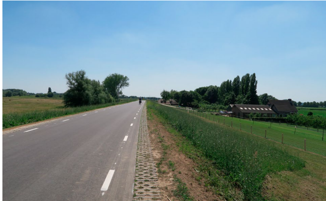
Afb. 2.51. Binnenberm met 1:10 talud en leeflaag. Berm is integraal onderdeel van aangrenzende kavel. Locatie: Beusichemsedijk 24-Lekdijk West Beusichem
