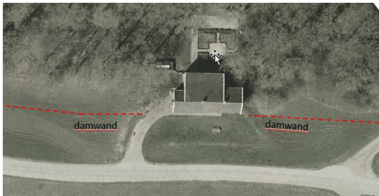
Figuur 15-6: Aansluiting damwanden aan weerszijden van Waldijk 11
