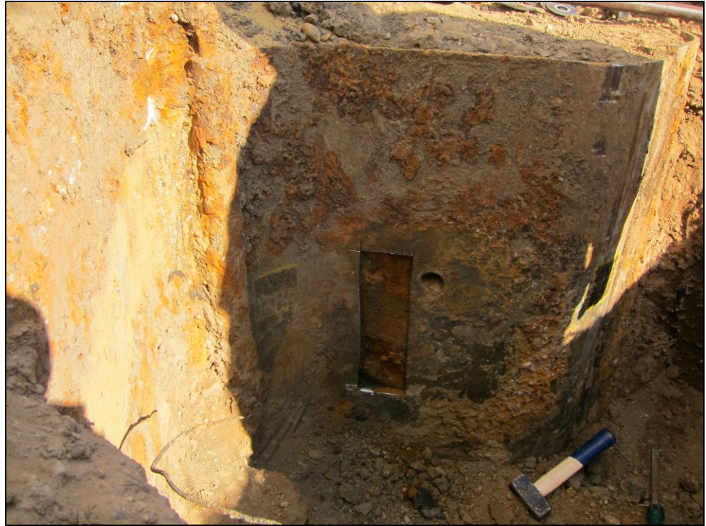
Foto 53: Staalcoupon verwijderd locatie 6.
