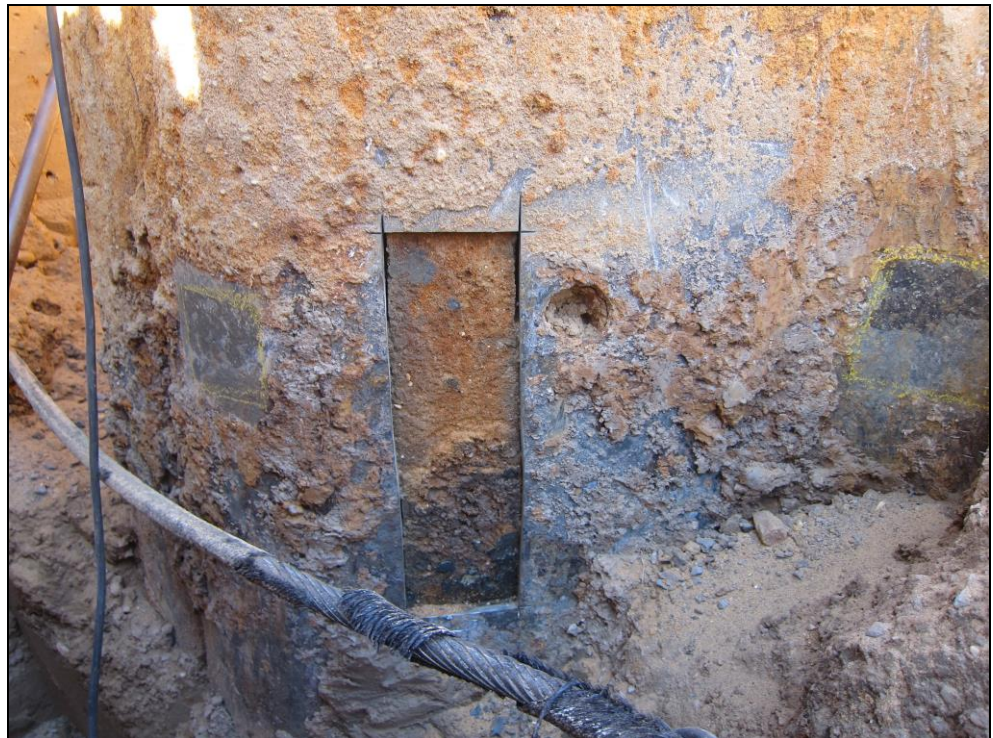
Foto 34: Staalcoupons verwijderd locatie 4.
