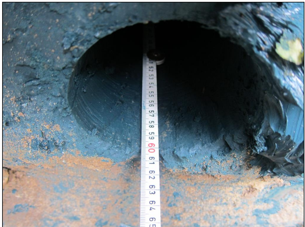
Foto 24: Dikte CB-wand, na ontgraven.
