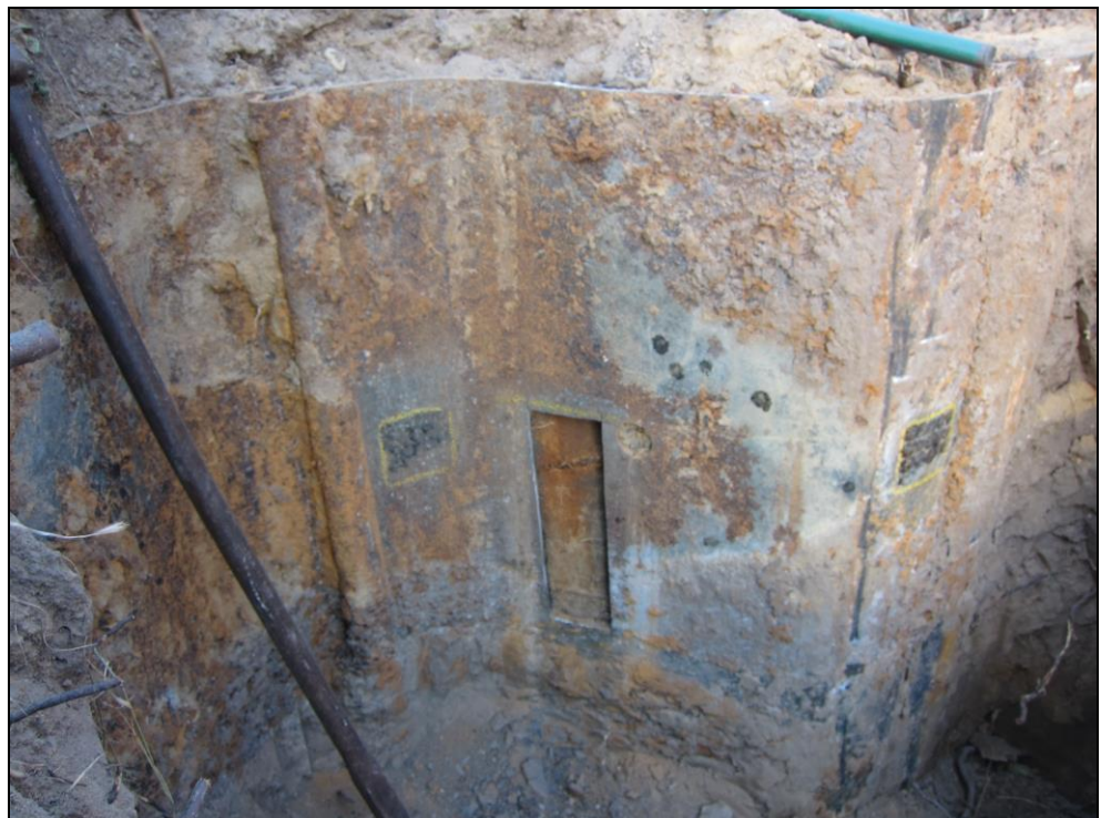
Foto 42: Staalcoupon verwijderd locatie 5.
