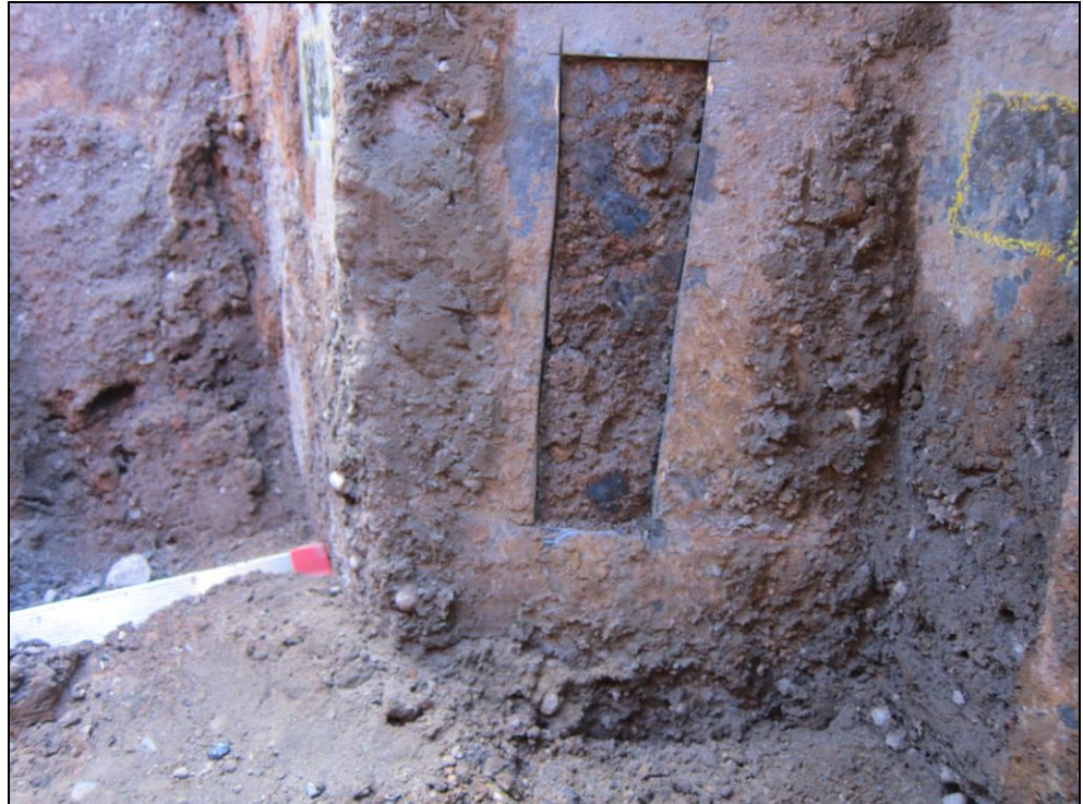
Foto 9: Staalcoupon verwijderd locatie 1.
