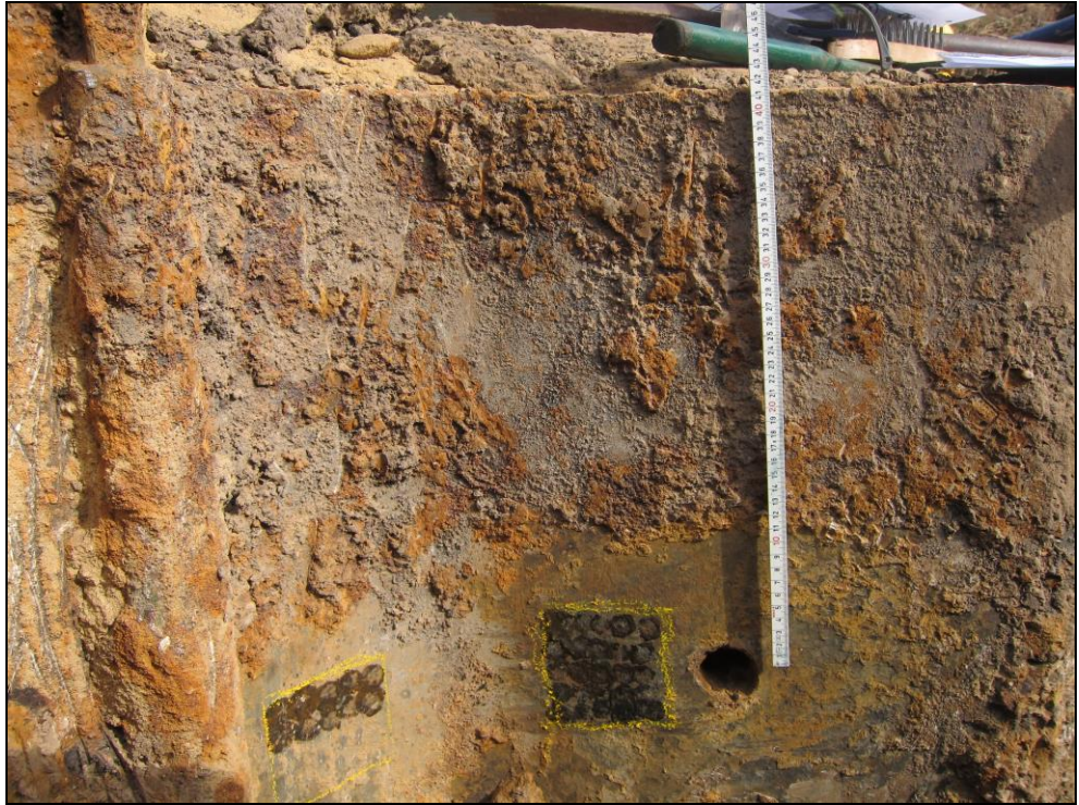
Foto 47: Gat op ca. -0,42 m t.o.v. bovenzijde damwand.
