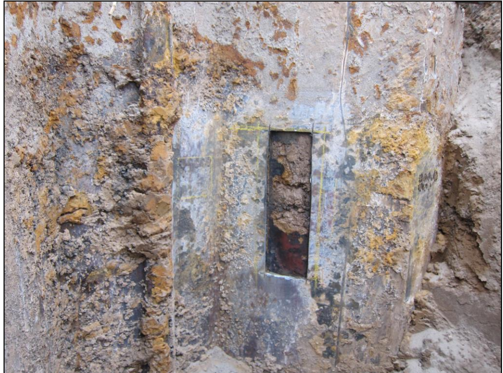
Foto 61: Staalcoupon verwijderd locatie 7.
