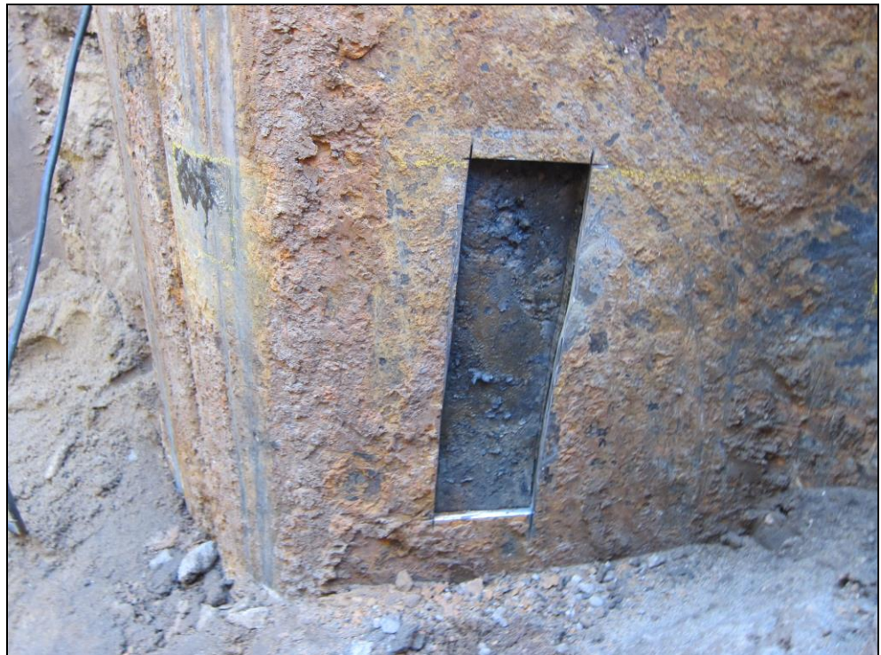
Foto 18: Staalcoupons verwijderd locatie 2.
