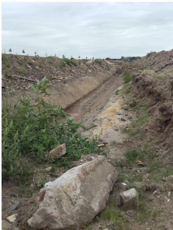
Figuur 4. Impressie van een recent gegraven greppel door de puinlaag ter hoogte van de boringen 50 en 329 t/m 331.
