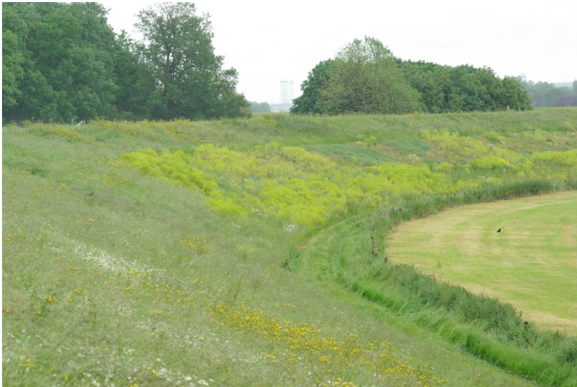
Afbeelding 2.8 Impressies dijktraject, foto 1 met zicht op buitendijks gebied ter hoogte van dijksectie 14, foto 2 met zicht op buitendijks gebied ter hoogte van dijksectie 10
