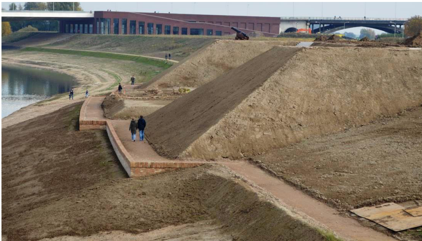
Fort Knodsenburg weer zichtbaar gemaakt op het nieuwe eiland Veur-Lent
